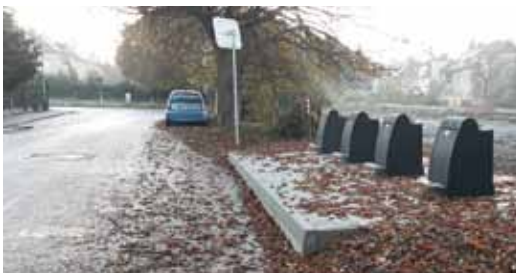
Další podzemní kontejnerové stání na tříděný odpad přibýlo v Nerudově ulici. Foto: Radim Tuček
